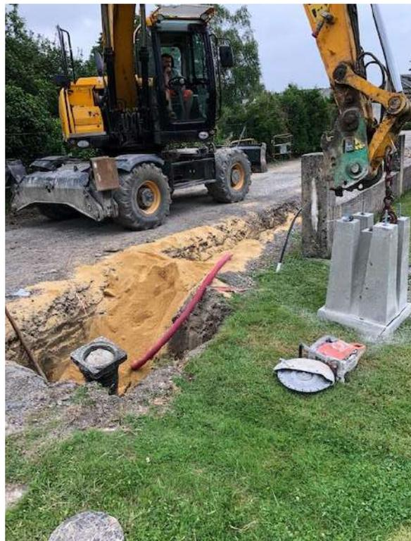
Puis la canalisation d'eau est mise en place afin de mettre les compteurs d'eau devant chaque propriété, dans le même temps les fourreaux et le massif pour l'éclairage public sont installés. Mi-juillet, les bordures et les caniveaux sont posés le long des habitations.
