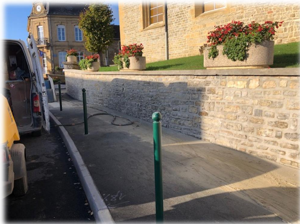
Mur de soutènement de l'église
