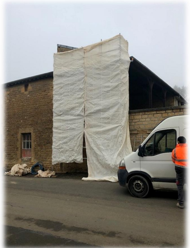
Pignon du préau de la cour de la mairie
