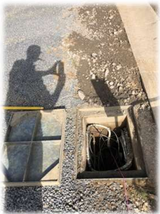
Pose des réseaux secs pour la fibre et l'électricité
