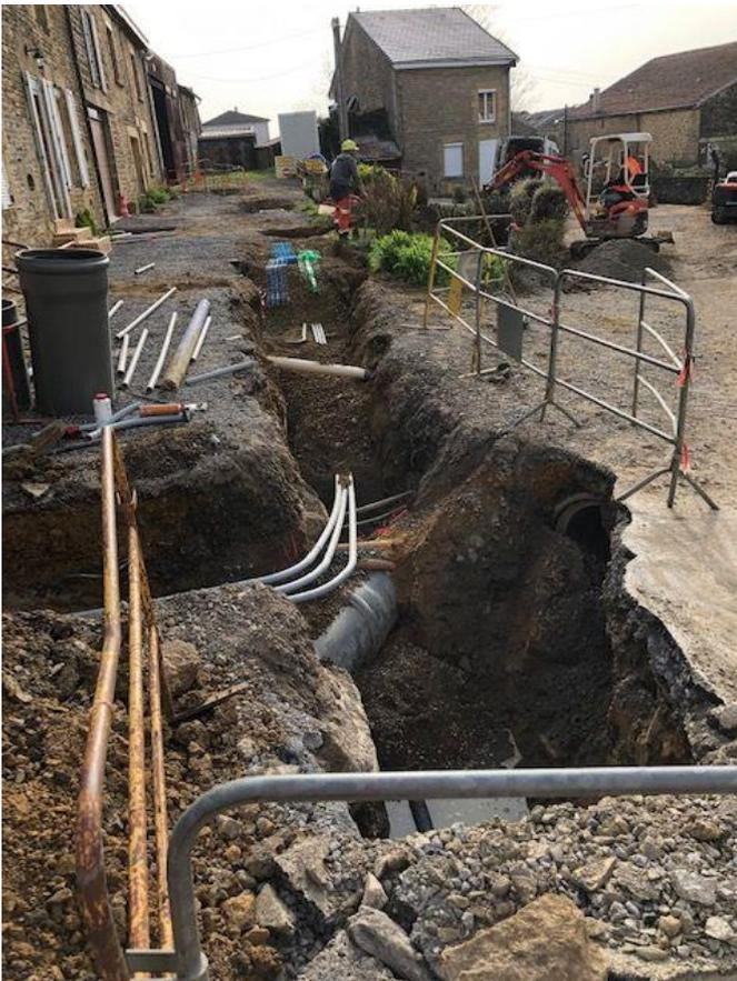
Après le réseau d'eau pluviale, c'est au tour de l'enfouissement des réseaux de télécommunications et d'électricité, avec la pose des chambres et des gaines qui permettront à la Fédération d'Électricité des Ardennes de câbler l'ensemble des habitations en sous-terrain.
