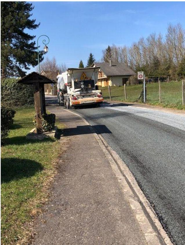
Dans le même temps, comme les conditions météo le permettent, la Sté Eiffage réalise une reprise des défauts du gravillonnage du grand lotissement, rue du Pré Clet et rue du Cochet. Cela permettra de maintenir la structure dans un état plus que correct.
