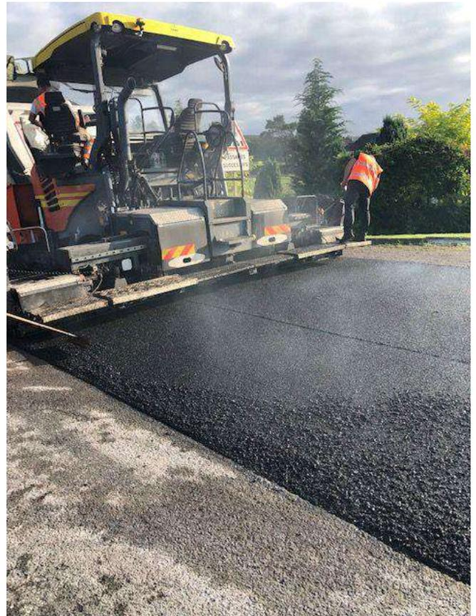
Après la mise à niveau des regards et des tampons, le jeudi 16/09 le village est entièrement fermé à la circulation pour la pose de l'enrobé en une seule passe. Les travaux débutent du pont de Rouvroy.
