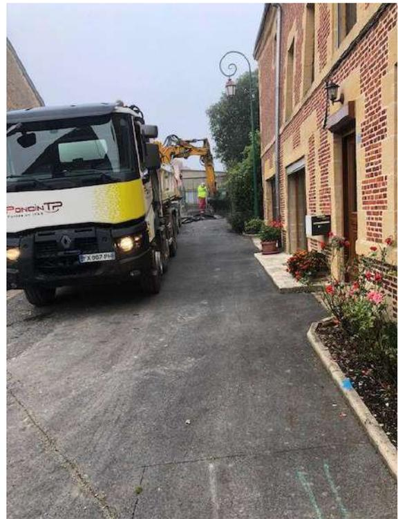
Les bordures de la voirie sont posées. Puis les travaux débutent ruelle Renaux par le décapage du bitume, la pose de nouveaux caniveaux et la préparation des surfaces.
