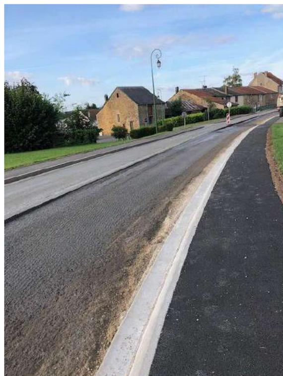
Mi-septembre, les travaux sur la RD968 commencent de l'entrée de Lonny au pont de Rouvroy, en intégrant le carrefour de Murtin jusqu'au niveau de la mairie. Tout d'abord le décapage de l'enrobé est réalisé par l'entreprise Colas sous la houlette du Conseil Départemental.
