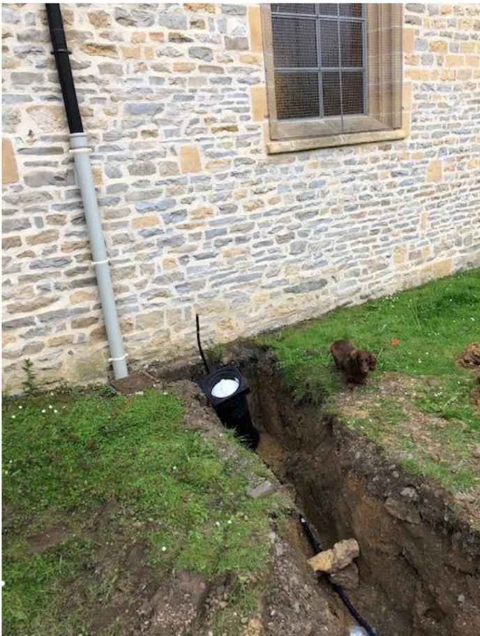
On profite de ces travaux pour mettre un branchement d'eau dans l'église, un compteur est installé le long du mur et l'alimentation se fait par le petit local de l'entrée.
