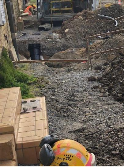
Après les réseaux d'électricité, de télécommunications et les canalisations d'eau pluviale qui ont été réalisés sur le derrière de l'église, l'entreprise Poncin pose à la mi-avril les compteurs d'eau en extérieur sur la partie arrière de l'église, puis réalise le réseau d'eau pluviale sur le devant en remontant le chemin d'Harcy.
