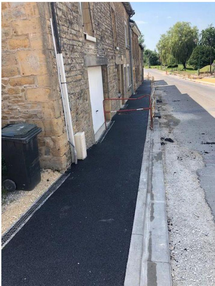
L'enrobé de finition est réalisé sur le trottoir de la rue de la Fontaine, pour permettre l'accès des habitants à leur garage.
