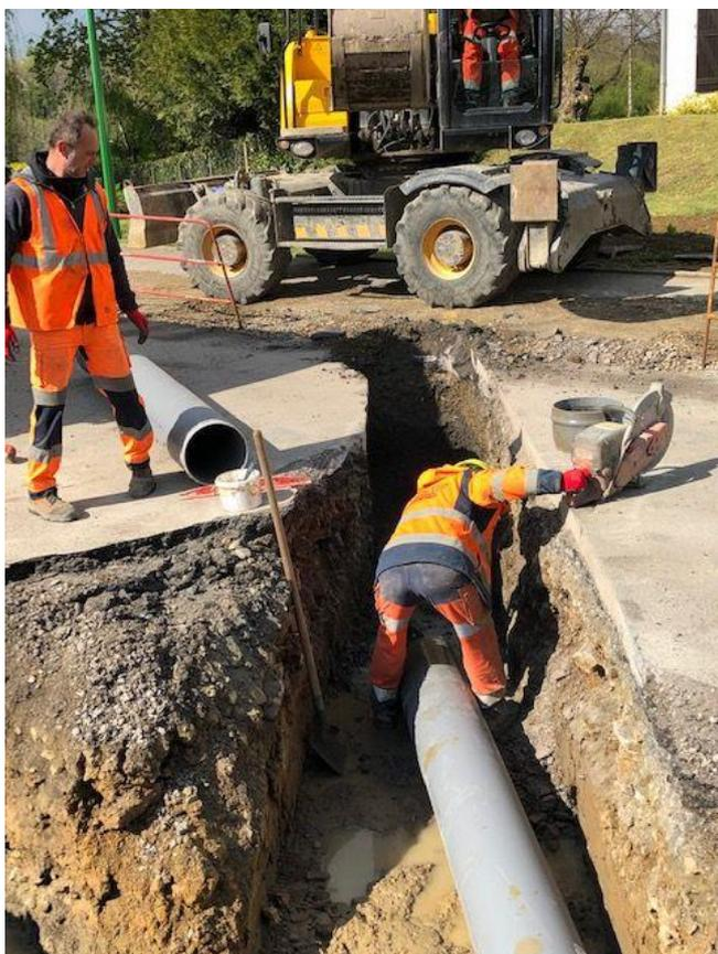
Les deux réseaux d'eau pluviale se raccordent en bas de la rue de la fontaine par la traversée de la route de Rouvroy sur Audry.
