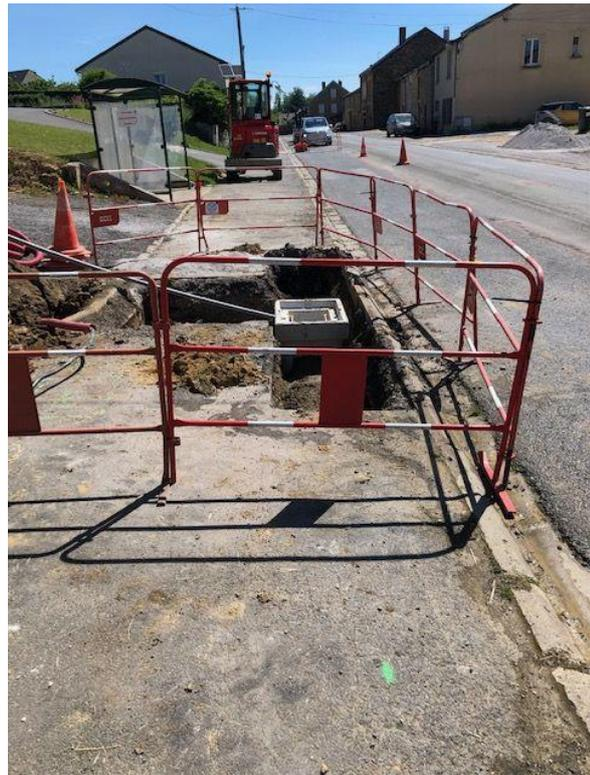
Avant la réfection de la route principale, il était nécessaire d'enfouir les derniers réseaux aériens d'électricité et de télécommunications. C'est chose faite. Avec la collaboration de la FDEA, l'entreprise SCEE réalise les travaux sur le mois de juin avec trois traversées de route.
