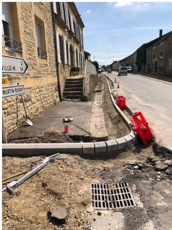
Puis c'est au tour du côté du perron, de recevoir un trottoir aux normes PMR, en réduisant la largeur de la chaussée.
